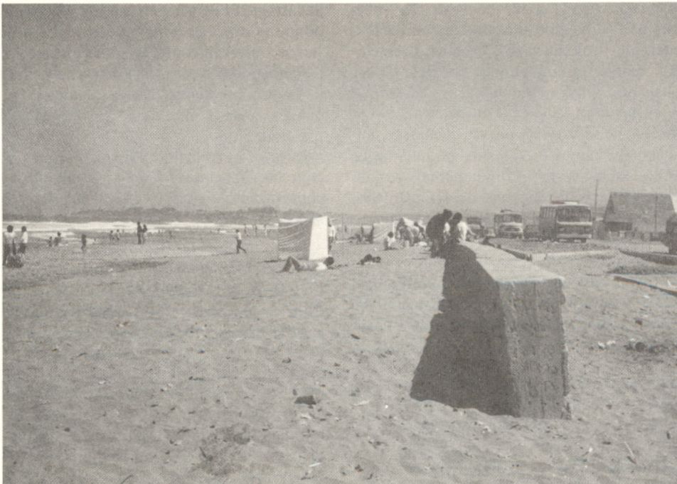
Foto 1: Costa Azul (Cartagena): Muro de protección que ocupa el lugar de una duna bordera.
