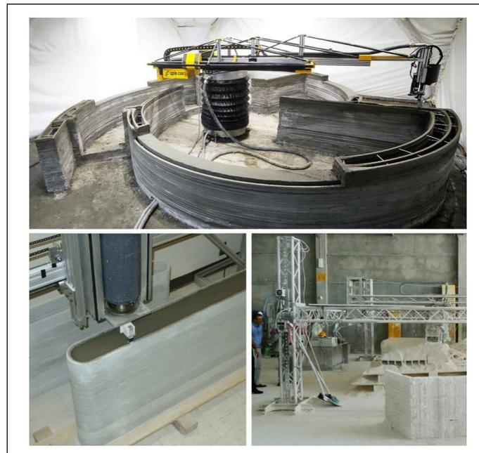
**Figura 1.** Tecnologías de construcción impresa en 3D (arriba: impresión de concreto, abajo-izquierda: elaboración de contornos, abajo-derecha: impresión D-Shape). Fuente: (Ghaffar et al., 2018) y (Ma et al., 2018)
