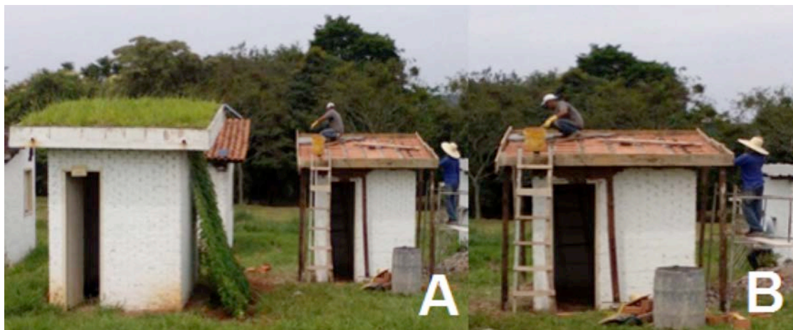
Figura 6. Construcción de cubiertas verdes (A) y (B). Fuente: Elaboración propia
