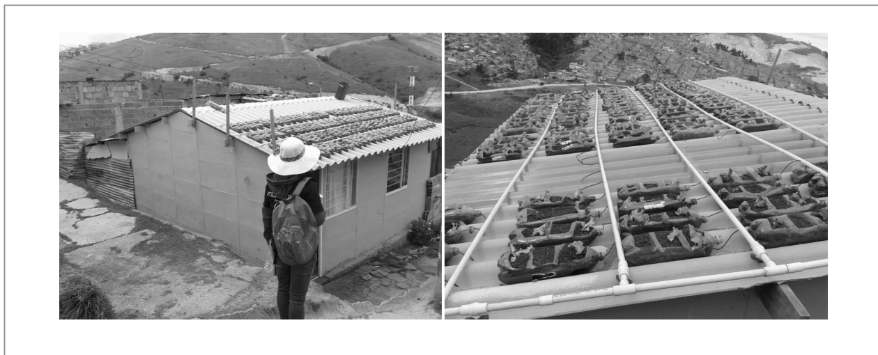
Figura 1. Imágenes de techo verde propuesto Figure 1. Image of the proposed green roof
