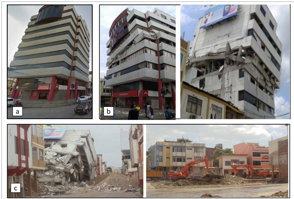
Figura 18. Principio y fin de una edificación dañada por el sismo del 16 de abril de 2016 que se llevó consigo muchas enseñanzas para la ingeniería que no se pudieron aprender
