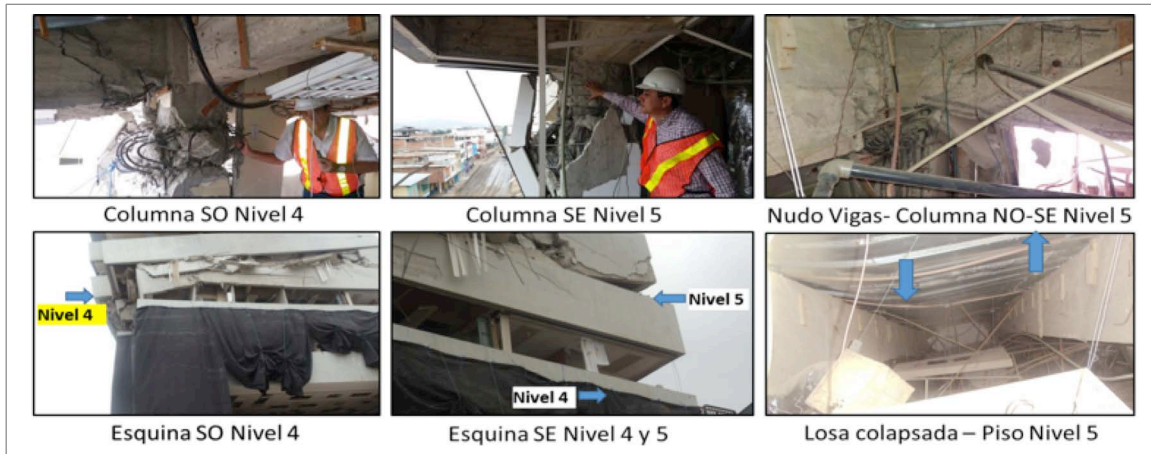
Figura 23. Columnas y vigas de los niveles 4 y 5
