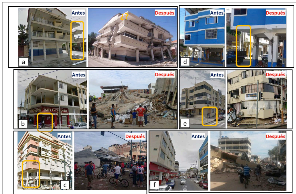
Figura 6. Otras edificaciones colapsadas en Portoviejo sin columna de esquina
