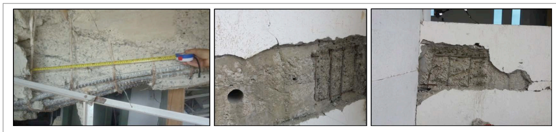
Figura 19. La investigación de una edificación requiere medir, extraer testigos, e incluso descubrir y reconocer que en ocasiones, mientras se estudia, pueden perderse las respuestas
