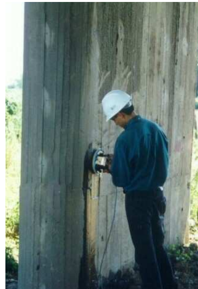
Figura 5. Medición de velocidad de corrosión empleando el GECOR 6.
