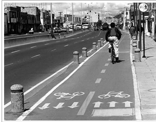
Figura 3. Sección de ciclorrutas sobre andén. Adaptado de www.idu.gov.co Figure 3. Bike-path section on platform. Adapted from www.idu.gov.co .
